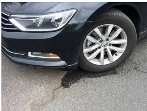
Instalovaný BÖRNER Rephalt je ihned zatížitelný
